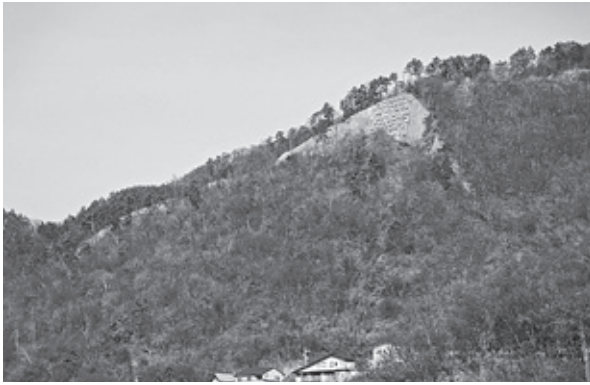
平成28年3月にのり面整備工事を完了した郷路山の山頂付近
