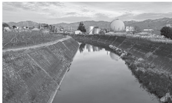
右岸（写真右側）の堤防かさ上げが事業化されている浅川
