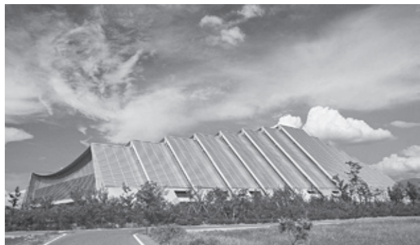
長寿命化改修工事の基本設計を行っているオリンピック記念アリーナ（エムウェーブ）
