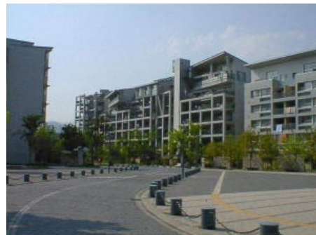
— 市営住宅 今井団地 —
