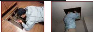
（土台・床組、基礎） （小屋組・梁） インスペクション現場（例）
