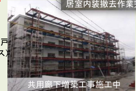
居室内装撤去作業完了
