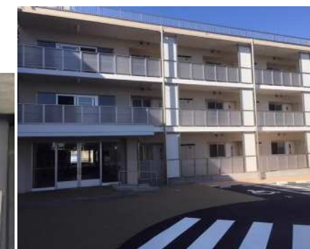
③E棟メインエントランス
