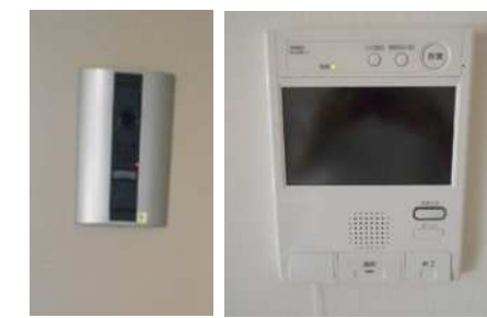
戸外表示器 (インターホン子機) 住宅情報盤 (インターホン親機)
