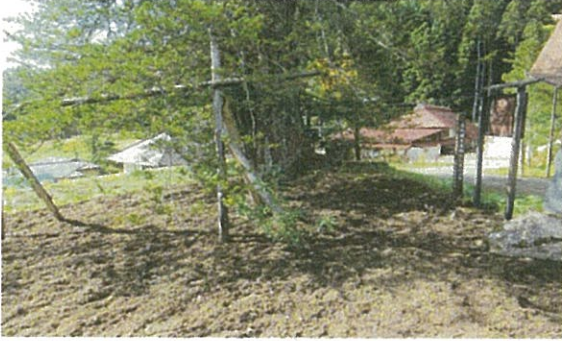
《作業_盛土撤去》
