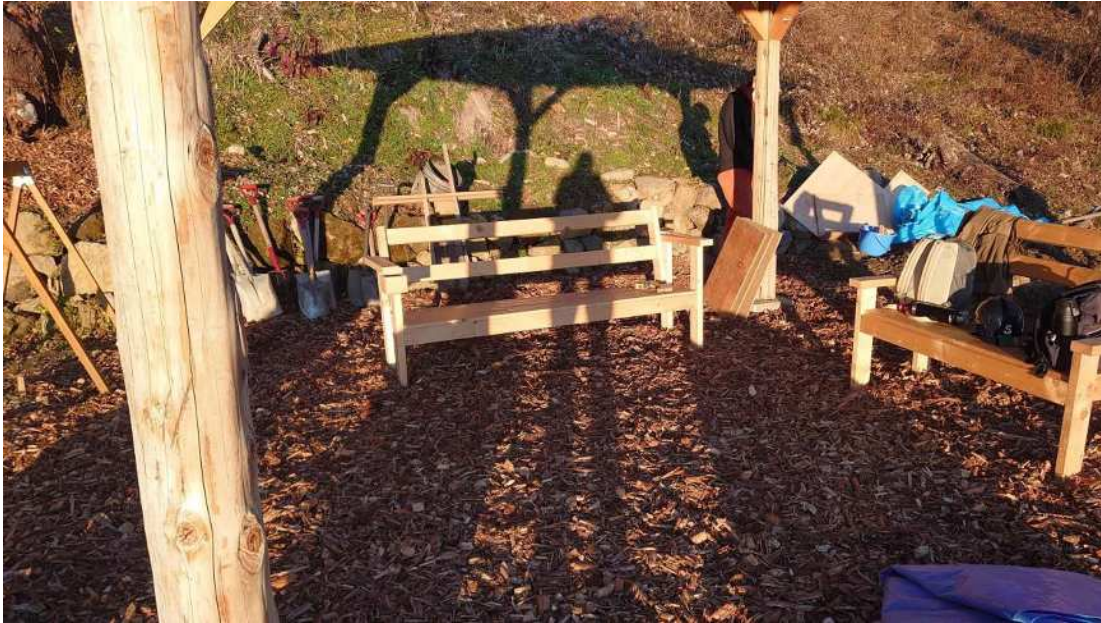
■ウッドチップ設置
