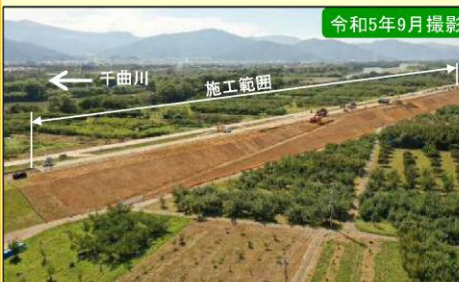
現地施工状況①
