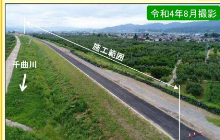
現地施工状況①
