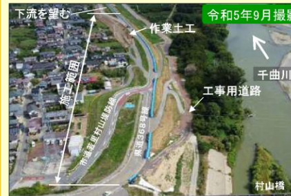
現地施工状況①
