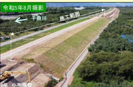
現地施工状況①
