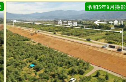
現地施工状況②
