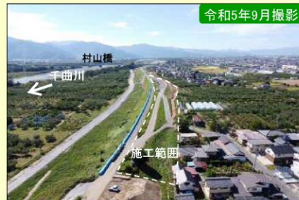
現地施工状況②
