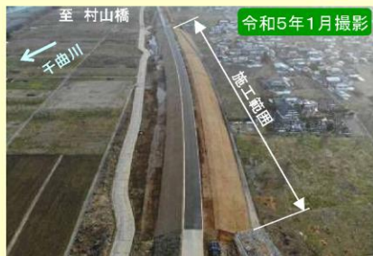
現地施工状況①
