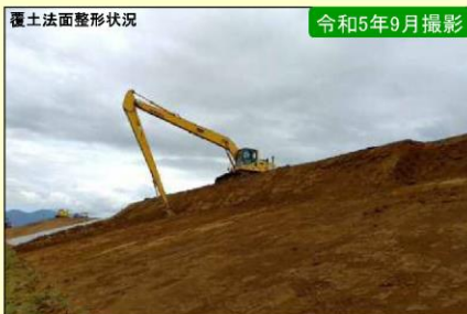
現地施工状況②
