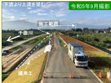
現地施工状況①
