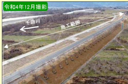
現地施工状況①
