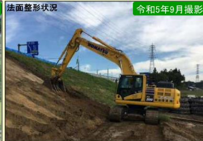
現地施工状況②
