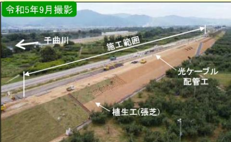
現地施工状況①
