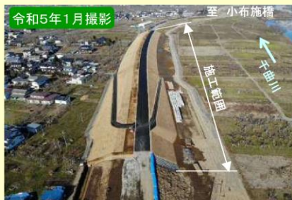
現地施工状況②
