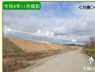
現地施工状況①
