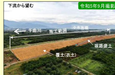
現地施工状況②
