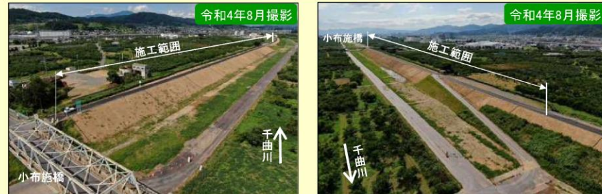
現地施工状況①
