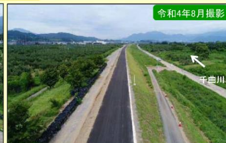
現地施工状況②
