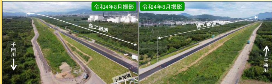
現地施工状況①
