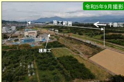
現地施工状況①
