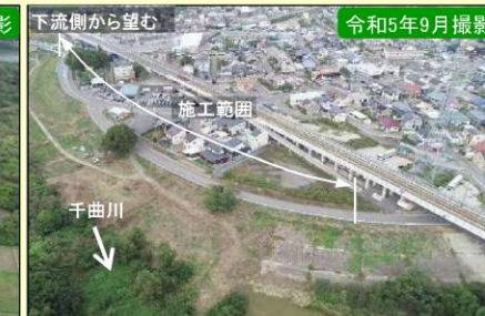
現地施工状況②
