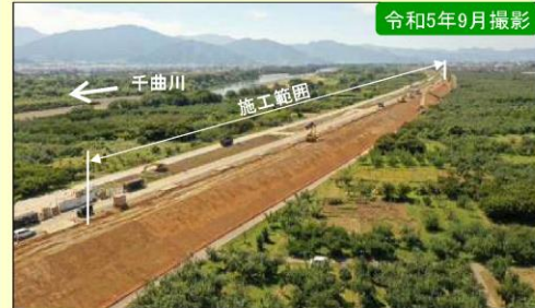
現地施工状況①
