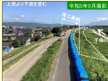
現地施工状況②
