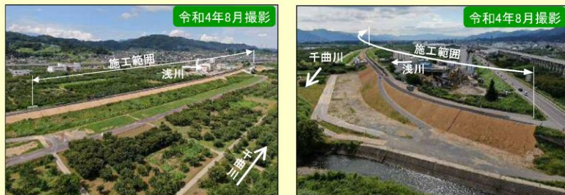
現地施工状況①
