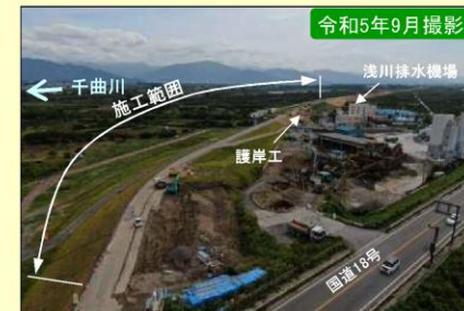
現地施工状況②
