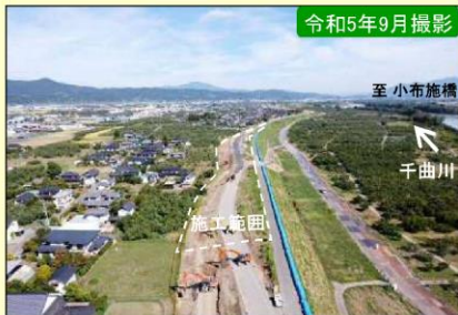
現地施工状況①
