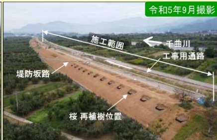
現地施工状況②
