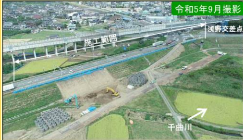
現地施工状況①
