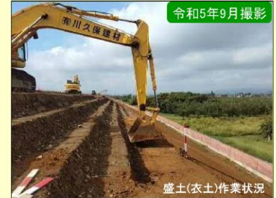
現地施工状況②
