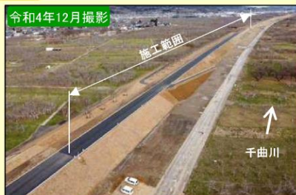
現地施工状況②
