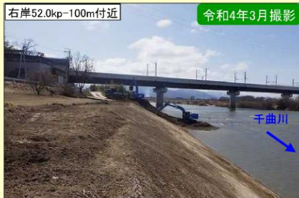
現地施工状況②
