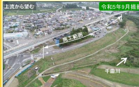
現地施工状況①
