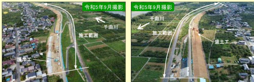
現地施工状況①
