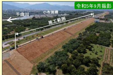
現地施工状況①
