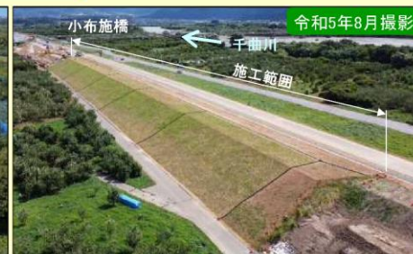
現地施工状況②
