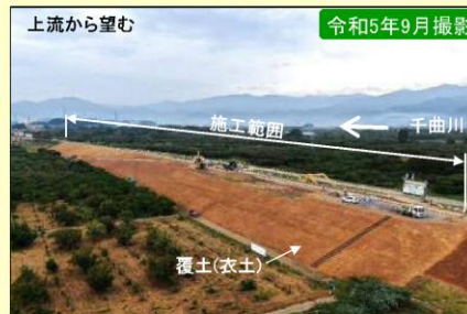
現地施工状況①
