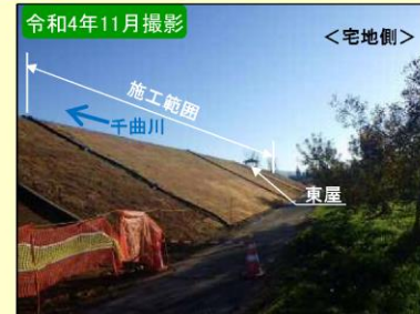
現地施工状況②
