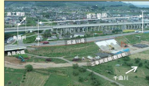
現地施工状況
