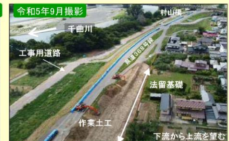
現地施工状況②
