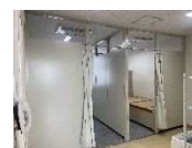
改修された女性用仮眠室
