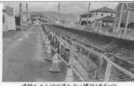
堤防かさ上げが進む北八幡川(東和田)
