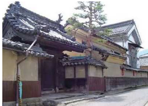
寺町商家(旧金箱家住宅) (長野市指定有形文化財(建造物)、 明治時代~大正時代)
