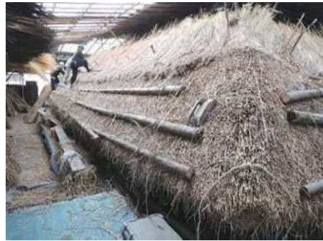
茅葺屋根の修理の様子
