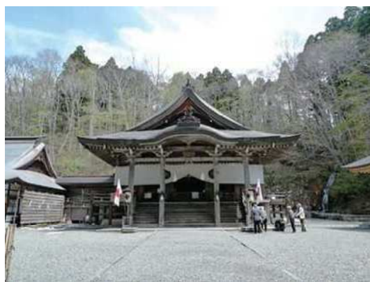
中社本殿(昭和31年(1956))
