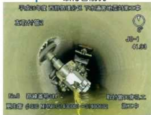
取付管削孔
