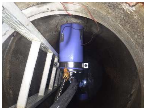
ストックマネジメント計画に基づき進む管更生工事
