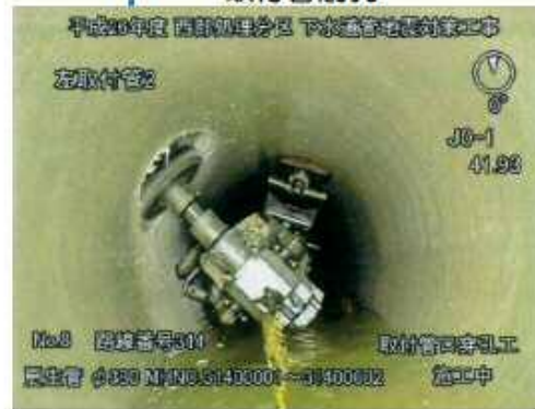
取付管削孔
