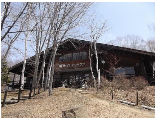
■長野市鏡池園地総合案内施設
