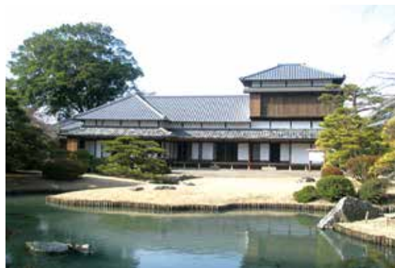
新御殿跡(真田邸) (元治元年(1864))
