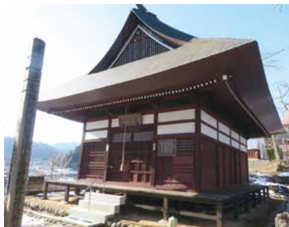
松巖寺観音堂 (長野市指定有形文化財(建造物)、 寛永2年(1625)又は寛永3年(1626))
