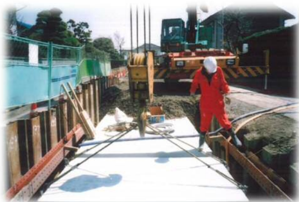
浅川1号雨水幹線工事 状況写真
