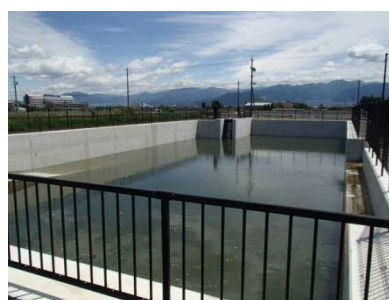
北堀雨水調整池
