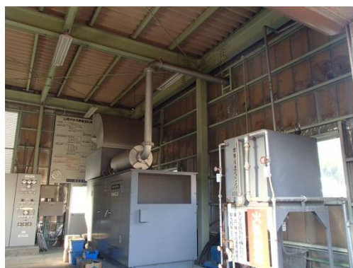
山根井ポンプ場（建物内部）
