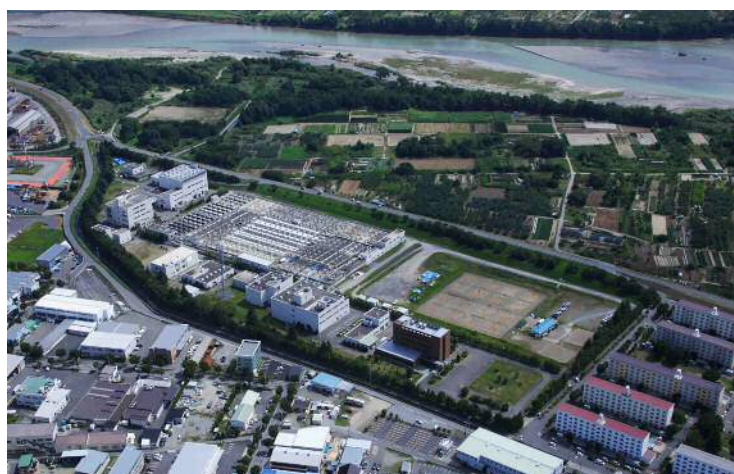
東部浄化センター 長野市大豆島地籍
