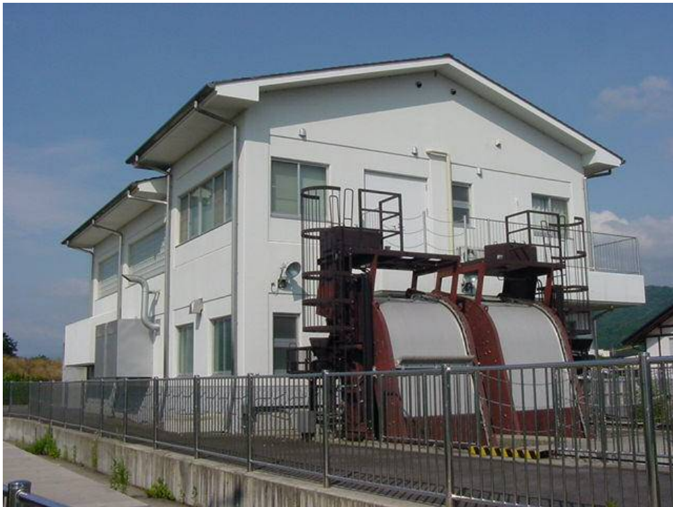
長野市公共下水道事業（雨水） 寺尾ポンプ場 平成12年供用開始
