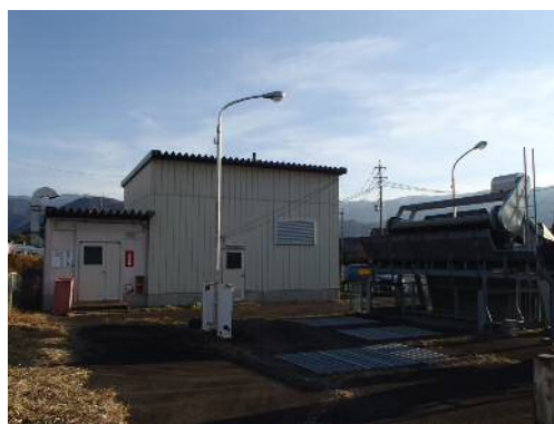
西田川ポンプ場（全景②）
