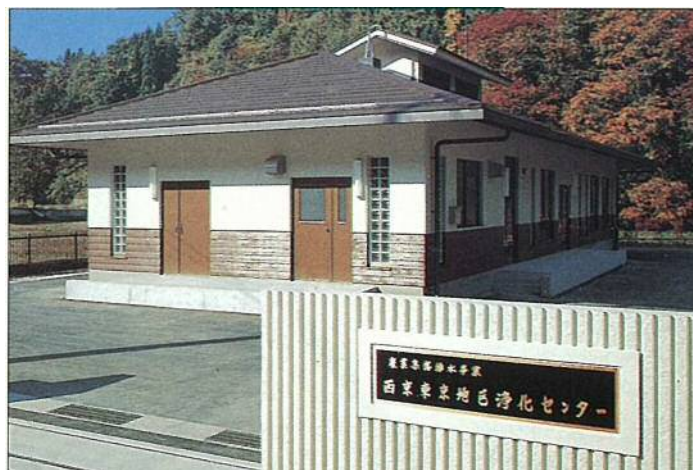
西京東京地区浄化センター
