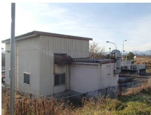
西田川ポンプ場（全景①）
