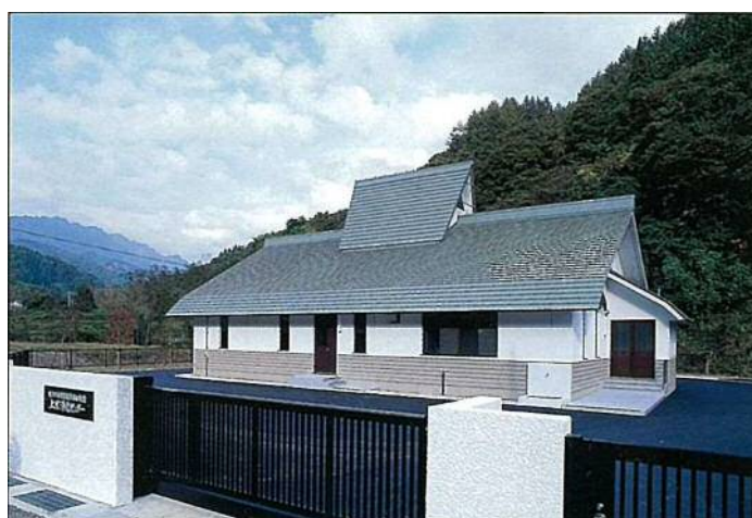
西京東京地区浄化センター
