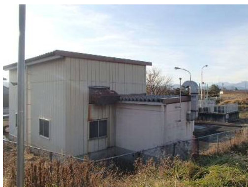
西田川ポンプ場（全景①）
