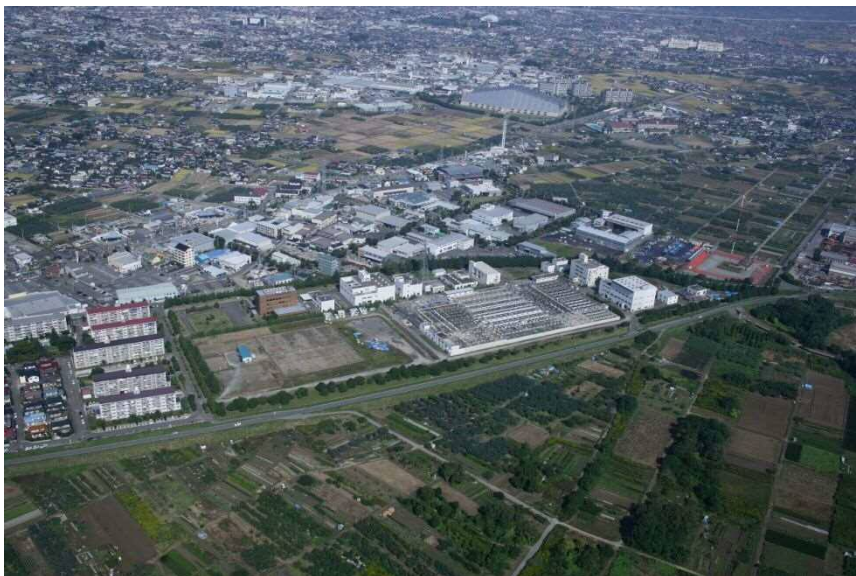
東部浄化センター 長野市大豆島地籍
