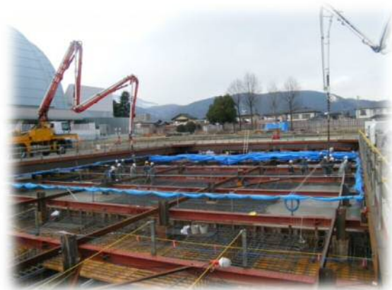
運動公園雨水調整池建設工事 状況写真
