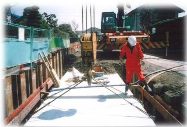
浅川1号雨水幹線工事 状況写真
