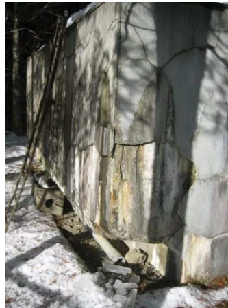
沈殿池 外壁 経年劣化による老朽化
