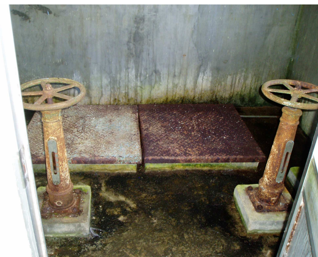
仕切弁・開口部の状況
