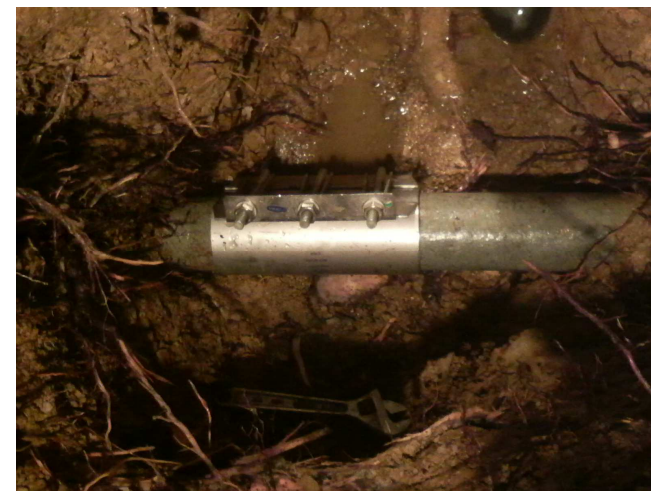
クランプによる修繕
