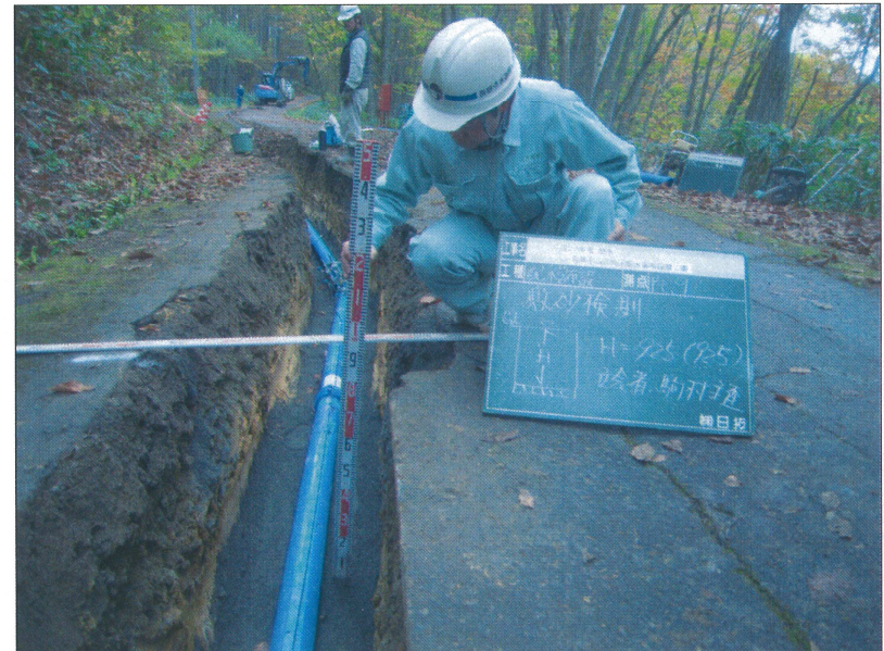
布設替え状況
