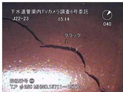
管渠内部（側面）
