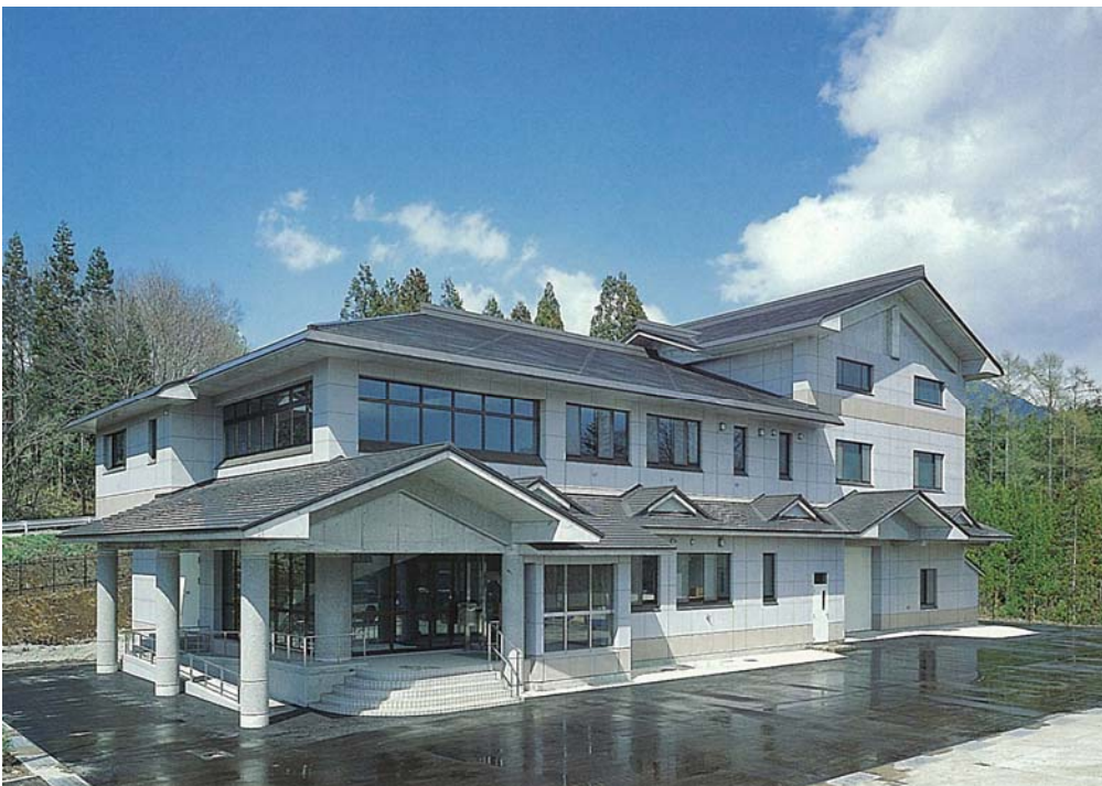
戸隠高原浄化センター
