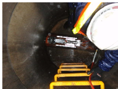
マンホール内
