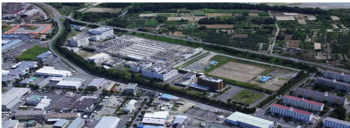
東部浄化センター 平成 19 年
