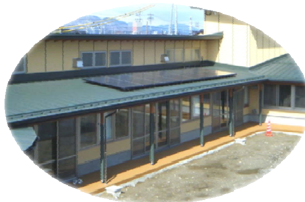
西部保育園の太陽光パネル
