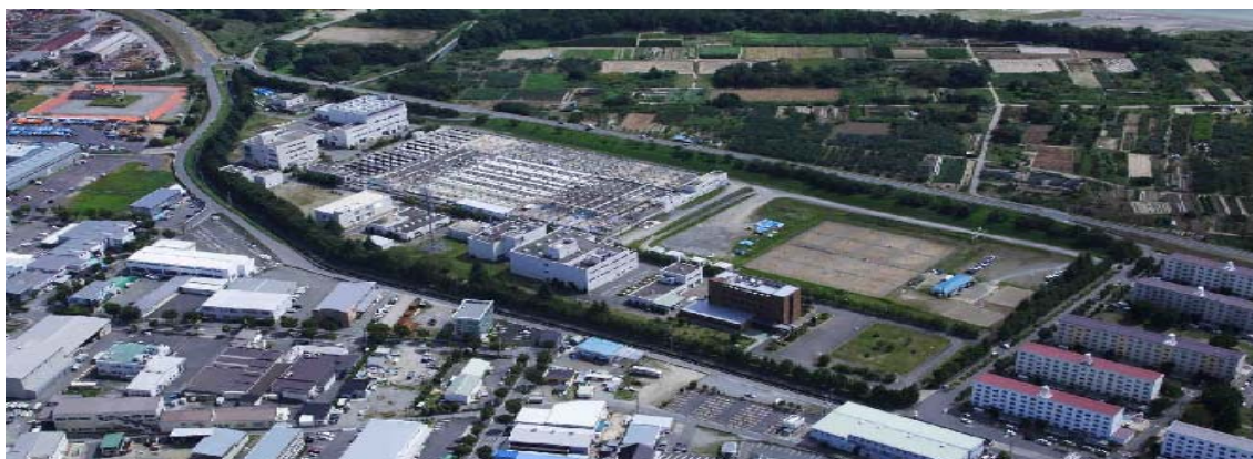
東部浄化センター 平成 19 年
