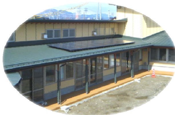
西部保育園の太陽光パネル
