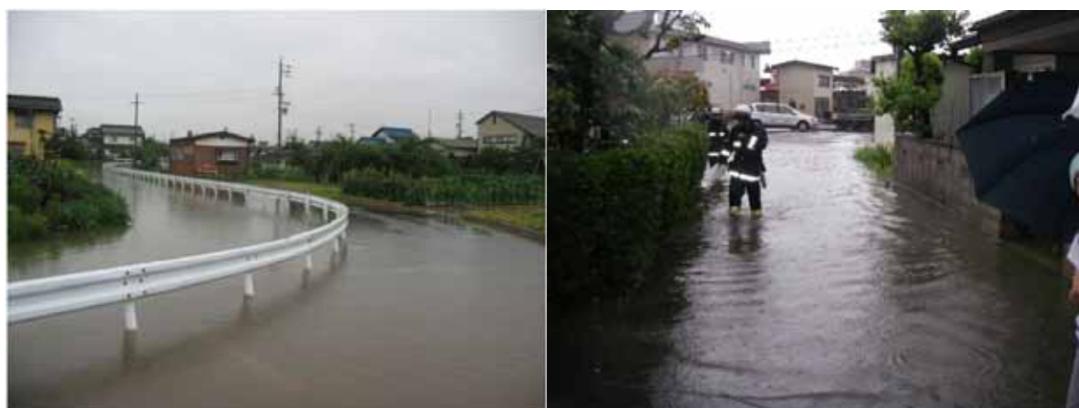
近年の浸水被害発生状況（長野市内）
