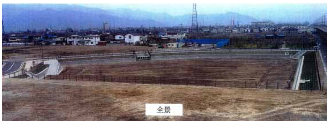
今井雨水調整池 平成 12 年
