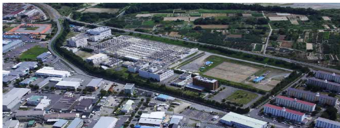
東部浄化センター 平成 19 年
