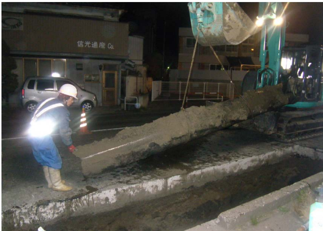
老朽配水幹線撤去状況（昭和29年供用開始 \phi 400 mm）
