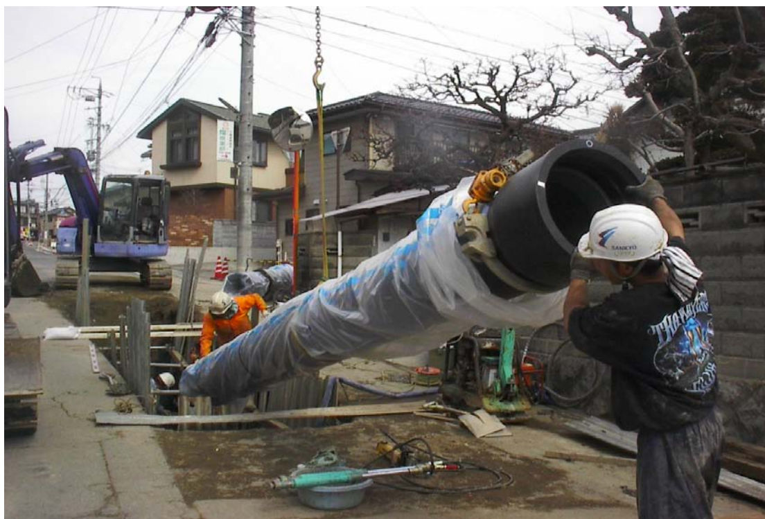
老朽配水幹線更新状況（ \phi 450 mm）
