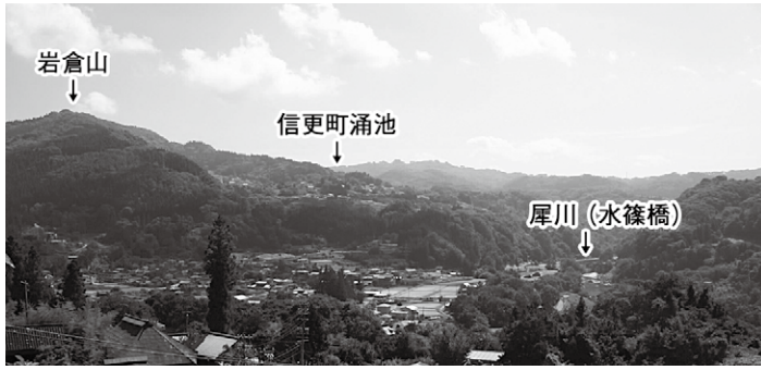
岩倉山の崩壊した跡
