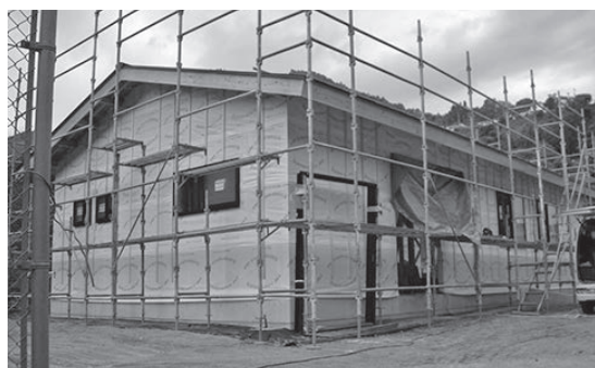
建設中の茂菅公民館
