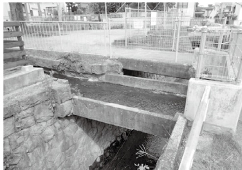
淀ヶ橋での湯福川との立体交差
