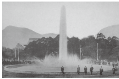
竣工当時の大噴水
