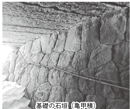
基礎の石垣(亀甲積)
