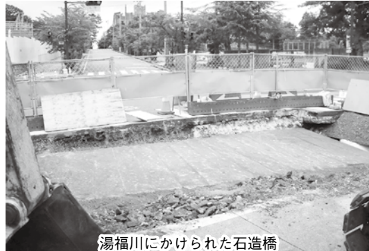
湯福川にかけられた石造橋
