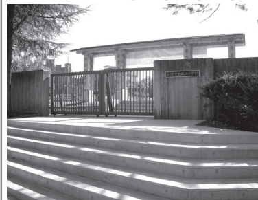
階段が整備された北門
