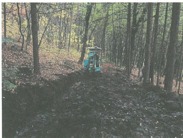
R4. 11. 13 暗渠設置作業 (3名参加)
