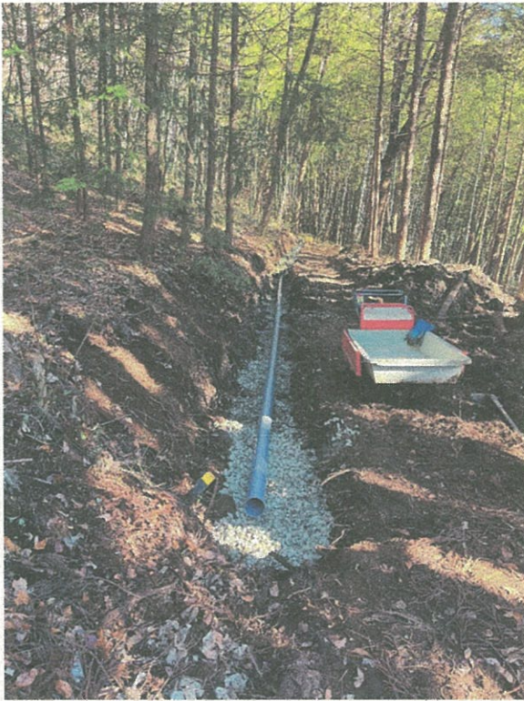
R4. 12. 10 暗渠設置作業 (4名参加)
