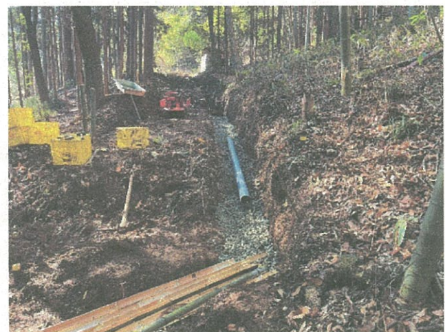
R4. 12. 3 暗渠設置作業 (3名参加)
