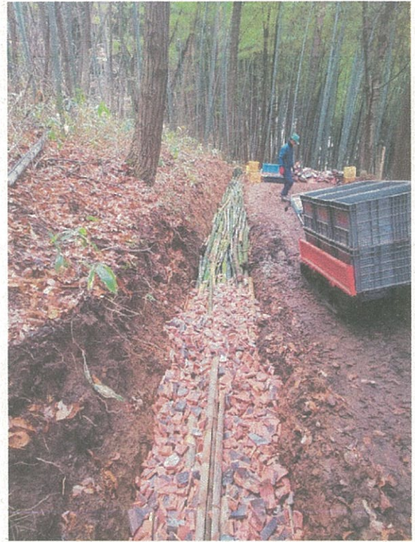
R4. 12. 18 暗渠設置作業 (4名参加)
