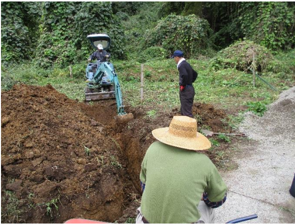
令和4年9月2日 作業中
