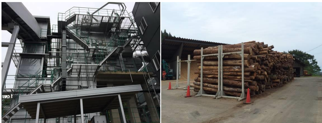
木質バイオマス発電所
