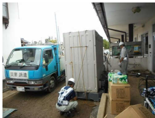
倉敷市からの仮設トイレ
