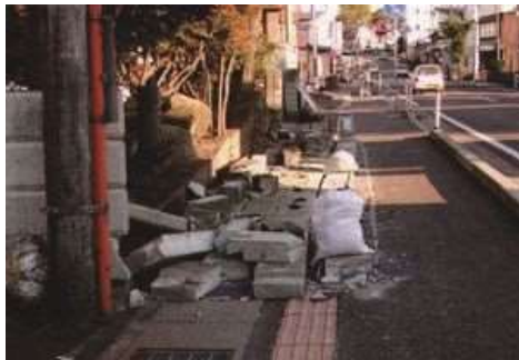
ブロック塀の崩落
