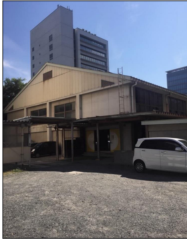
位置: 体育館 外観 撮影日: 平成30年6月22
