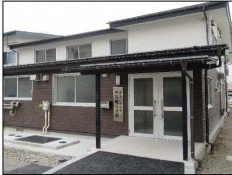
中部公民館第五地区分館 【築41年】
