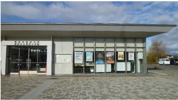
柳原支所 外観(正面)
