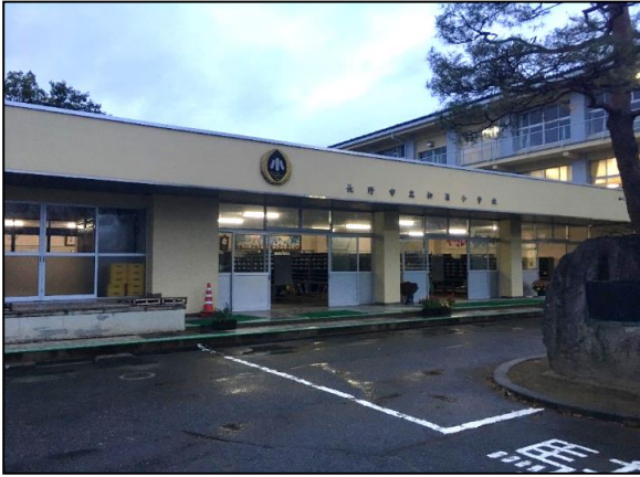
昇降口棟 外観
