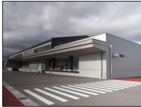
第四学校給食センター 【築1年】
