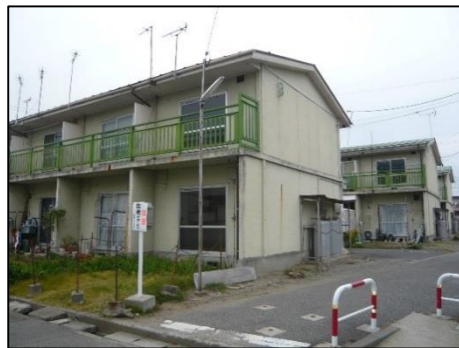
市営住宅小島団地 【築42年】
