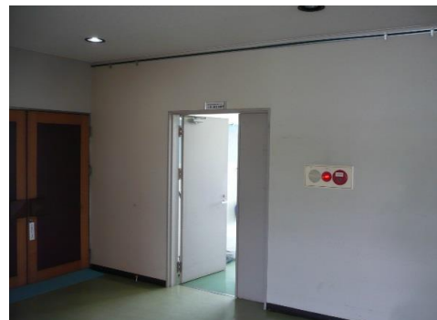
建物内部(第2作業室)
