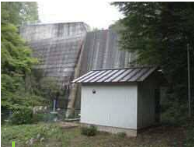
発電所、砂防ダム
