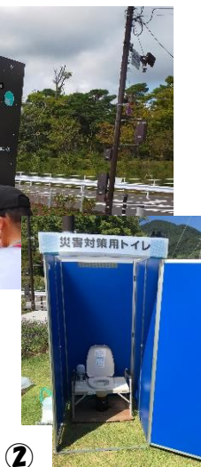
② 災害対策用 マンホールトイレ
