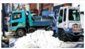
南石堂町では、2月21日（金）から23日（日）の3日間にわたり、平和通り（道路幅6mの近畿日本ツーリストから金沢工業の国道19号までの間）の生活道路の除雪を行いました。2tダンプカー3台とバックホンの重機2台で、約20cmの雪がコンクリートのように堅く固まっている氷状の雪を取り除く作業を行いました。懸命な作業にもかかわらず、作業の効率はなかなか上がりず困難を強いられましたが、見事にきれいに除雪されました。
