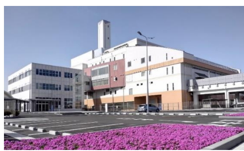
ちくま環境エネルギーセンター
