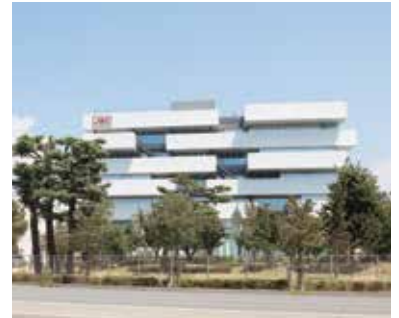
127 日本無線 先端技術センター
