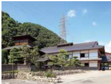
111 すき亭本館と洗心亭
