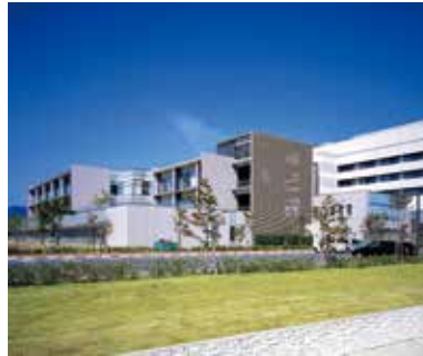
97 長野市民病院 中央棟、南病棟 (公共)
