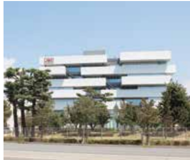
127 日本無線 先端技術センター
