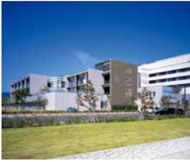
97 長野市民病院 中央棟、南病棟 (公共)
