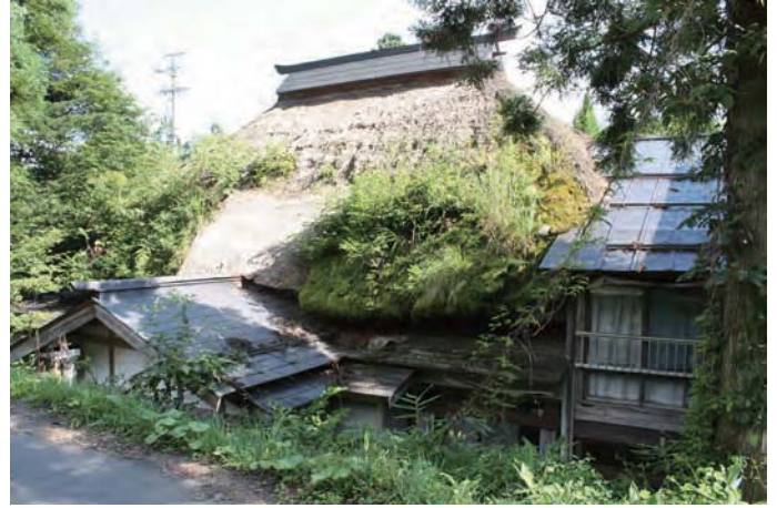
写真2 宿坊外観（北西から）
