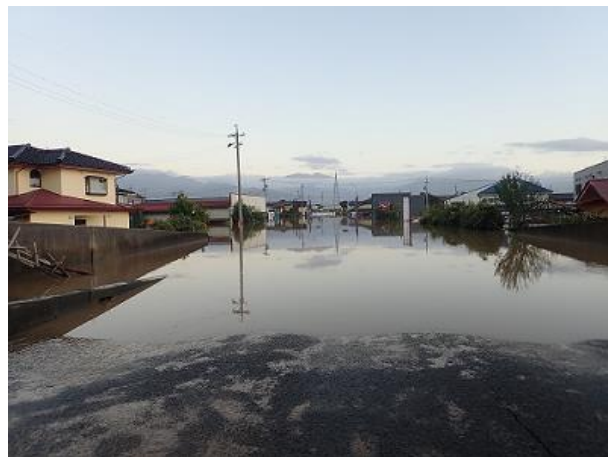
水没民家②（令和元年10月14日豊野地区）
